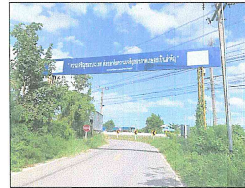
รูปด้านหลัง ป้าย หมู่ที่ 2 (ป้ายเดิม)
